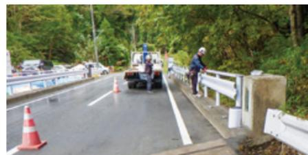
本工事では、舗装打替え作業、主桁塗り替え作業が終了。現在は、地震時などに橋の主桁にかかるエネルギーを分散させる水平分担装置の取付作業に入っています。工事も終盤に入っておりますが、住民の皆さまのご不便に配慮しながら、安全な現場管理に努めてまいります。
