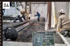
04 高橋製作所 立旋盤機械基礎工事
