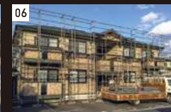
05 青森ポートリー 仏鶏糞醗酵屋根修繕工事
