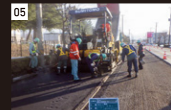
04 八戸北インター第2工業団地調整池工事
