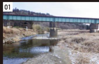
01 夏井川B洗堀対策工事
