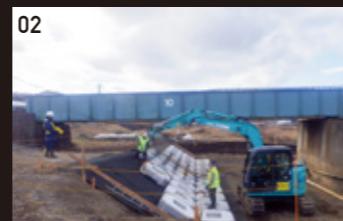
02 久慈構内久慈川B洗堀対策工事
