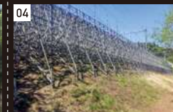
04 八戸・七戸十和田間防音壁高上げ工事
