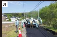
01 坂牛新都市線道路修繕(打換)工事
