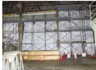
【三菱製紙】構内修繕工事
