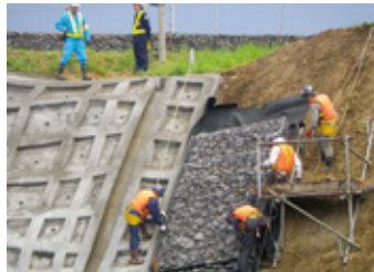
【JR八戸線】災害復旧工事
