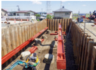
【八戸市】新大橋河原木跨線橋整備工事
