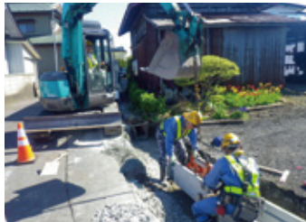
【八戸市】悪虫線ほか道路修繕打換工事
